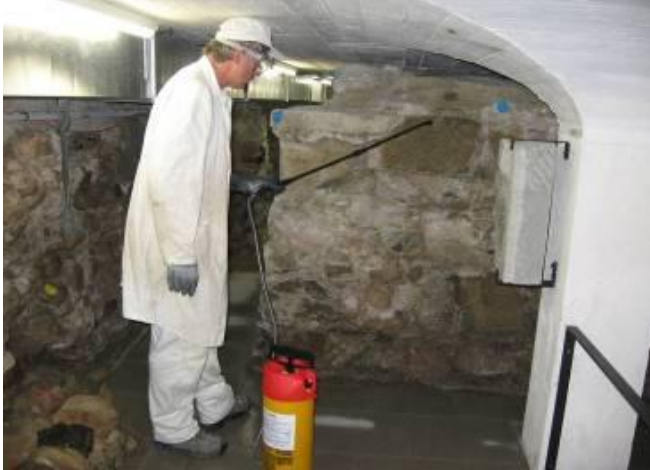
Bild: Schimmelsanierung mit Sanosil Schimmelstopp in der Krypta einer Kirche in Zürich
