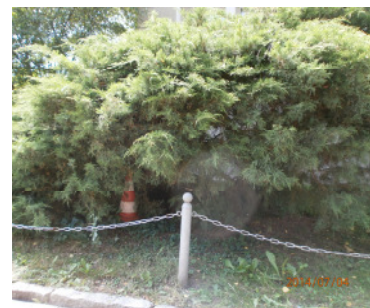
Hydrant schwer auffindbar (erdüberdeckt/überwachsen)
