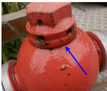
undichte Stopfbuchse
