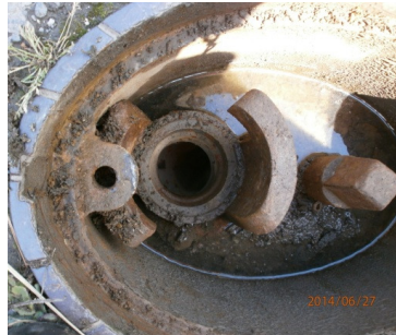
Hydrant nicht nutzbar, da z.B. Kappe versetzt, Zaun überbaut ...
