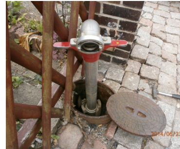
Hydrant nicht nutzbar, da z.B. Kappe versetzt, Zaun überbaut ...
